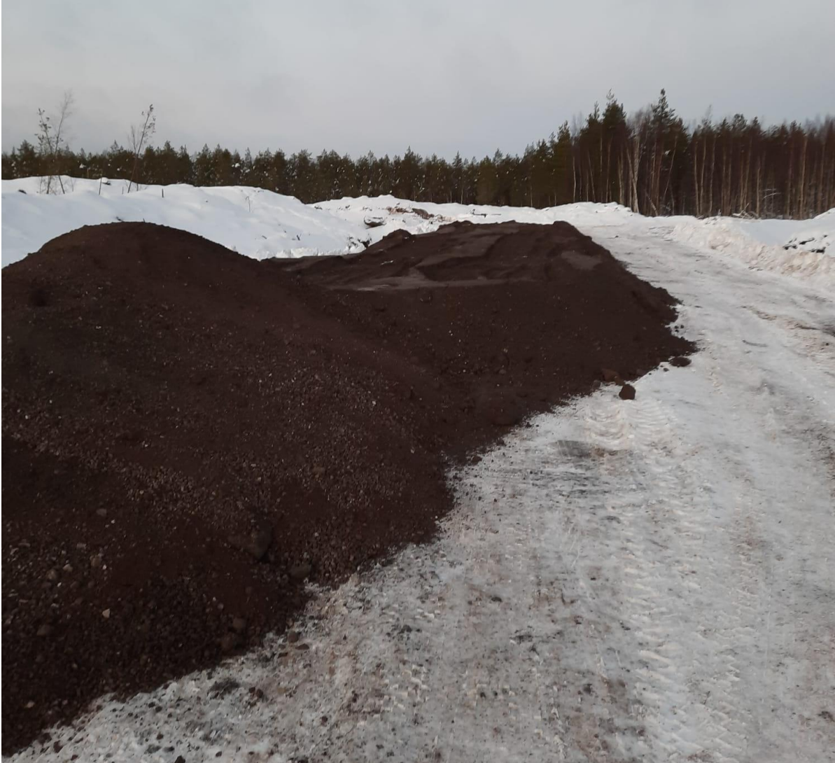
Kuva 6-1. Päästö- ja kustannuslaskuria voi hyödyntää esimerkiksi maanrakennuskohteeseen vertailemalla uusiomateriaalin ja neitseellisen materiaalin käytön vaikutuksia päästöihin ja kustannuksiin. Kuvassa pohjoisen osan kaavatien maanrakennustyössä käytettyä jätteenpolton pohjakuonaa (Kuva @ Petri Leskinen, Utajärven kunta).
