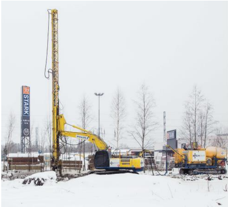
Kuva 3-2. Massastabiloinnissa käytettävä kaivinkonekalusto (ylhäällä) ja pilaristabiloinnissa käytettävä kaivinkonekalusto (alhaalla). (Kuvien lähteet Ramboll, 2019; Liikennevirasto 2018)
