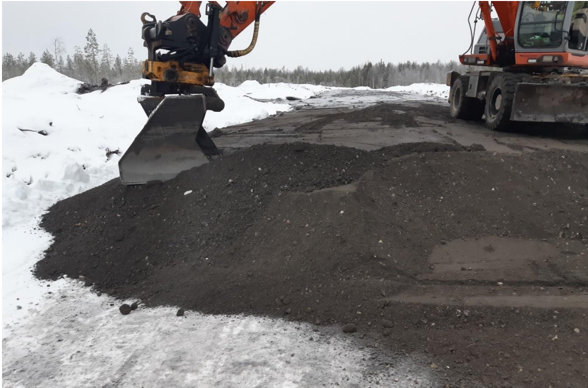
Kuva 6-4. Neitseellisen hiekan sijaan pohjoisen osan kaavatien rakentamisessa hyödynnettiin uusiomateriaalina jätteenpolton pohjakuonaa (Kuva @ Petri Leskinen, Utajärven kunta).
