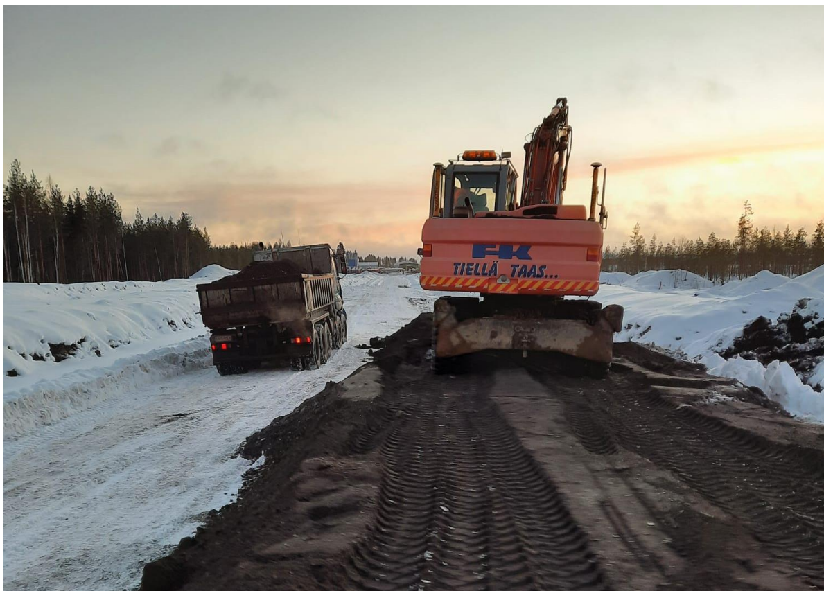
Kuva 6-5. Jätteen pohjakuonaa hyödynnettiin pohjoisen osan kaavatien maanrakentamisessa (Kuva @ Petri Leskinen, Utajärven kunta).
